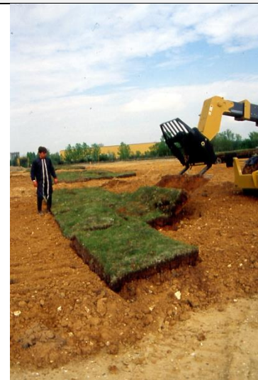
Etape 6 : repositionnement des plaques sur la zone réceptacle
