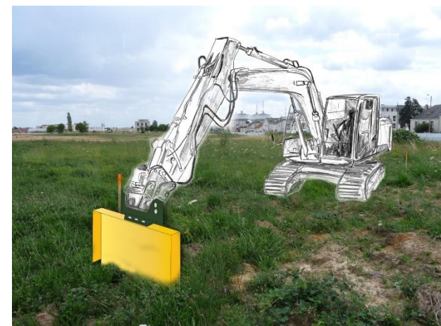
Etapes 2 et 3 : prédécoupage des bandes de 2m de large (à gauche), puis des plaques tous les mètres (à droite)
